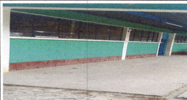
Foto 2: Pintura en muros exteriores e interiores
